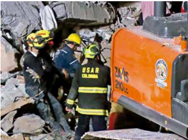
Mientras algunas calles están en completa oscuridad, hay otras que sólo se iluminan por las luces de las grúas de rescate.
